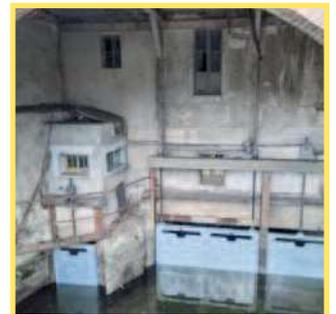
Photo 6 : Mise en eau réalisée/ vannes immergées prêtes à réguler sans manipulation humaine-24h/24, 7j/7
