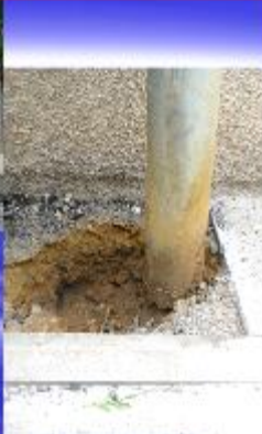
Terrassement des boîtes de tranchement
