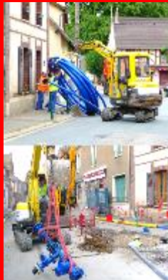
Installation des sautoirilles d'alimentation en eau potable
