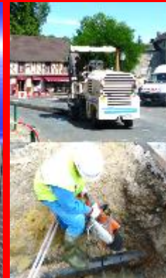
Installation des sautoirilles d'alimentation en eau potable
